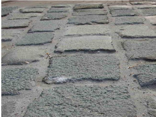
Anschließend wird die Fläche entsprechend dem Abtrag in den Fugen neu verfügt und ist wieder in einem gebrauchsfähigen und den Vorschriften entsprechenden Zustand.
