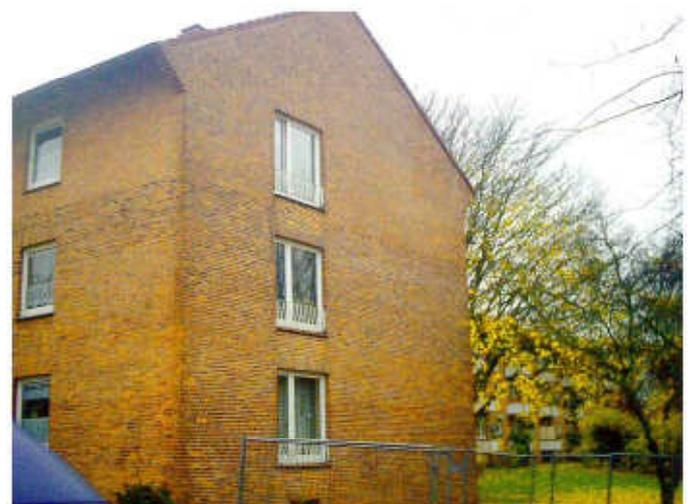
**Wohnhäuser in Lübeck.** Der Fugmörtel der Klinkerfassaden war bereits soweit verwittert, dass er bei der Fingerprobe an der Oberfläche absandete. Die Regenwasseraufnahme der Fugen ist in diesem Zustand bereits erheblich erhöht. Außerdem wurden an den links abgebildeten Häusern sogenannte Handformklinker verwendet, die zwar rustikal aussehen und (im trockenen Zustand) eine gute Wärmedämmung besitzen, aber auch sehr saugfähig sind.
