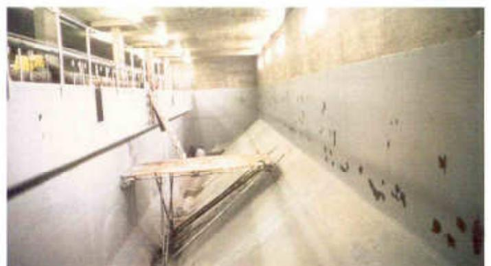
Abdichtung und Schutz eines unterirdischen Klärbeckens in Estavayer (Schweiz), mit PlastaPox UW, PlastaDur P und nachträglicher Beschichtung mit PlastaDur S
