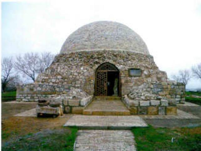
Die Außenflächen des Mausoleums wurden nach der Restaurierung mit Lotupor hydrophobiert, um die Regenwasser-Aufnahme zu verhindern
