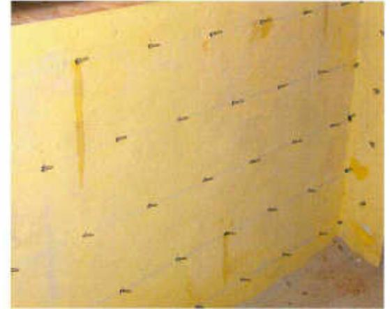
**Kreiskrankenhaus Stollberg**, Sachsen, der Altbau wurde aufwändig saniert und in diesem Zusammenhang auch gegen aufsteigende Feuchtigkeit und Querdurchfeuchtung der Wände abgesichert.
