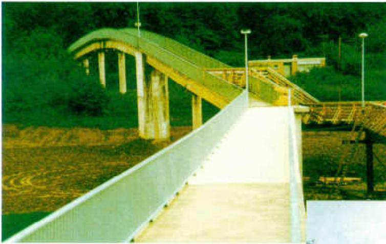
**Fußgängerbrücke über die Ruhr bei Arnsberg.** Beton-Oberflächenabdichtung mit PlastaDur P und PlastaPox UW
