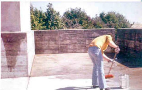
Betonschutz einer Lagerfläche für Alt-Akkus gegen Schwefelsäure im Werk Akku-Hagen in Soest
